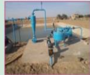
جاپانی منصوبہ سیلاب کے تحت ضلع ڈی جی خان میں نصب ہونے والا ڈرپ ایریگیشن سسٹم
